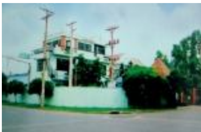
Nhà máy Kéo sợi Đông Tiến Hưng-GD 1.2
