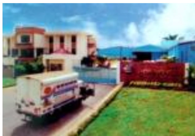
Nhà máy SX gạch men Hoàng Gia
