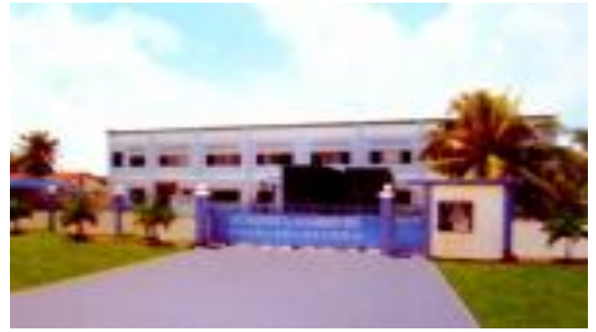
Xưởng may Tân Thành Đạt (Địa điểm: KCN Sóng Thần, Thuận An, Bình Dương)
